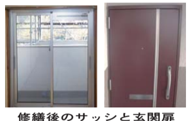
修繕後のサッシと玄関扉
