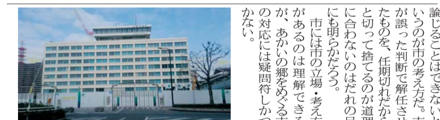
市庁舎の建設現場
